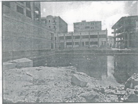
صورة ( ٢٢ ) ظهور الماء الأرضي عند الحفر لوضع الأساسات بمدينة
