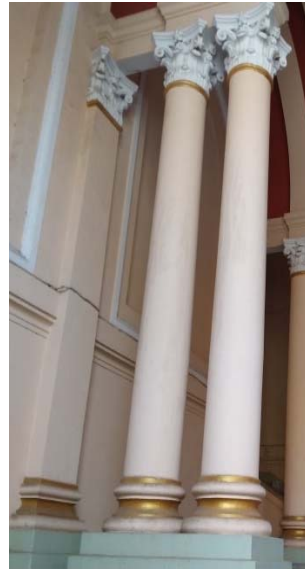
شكل 19. عمود من طراز العمود المركب يقابله فص من نفس نوع العمود ببهو المدخل الرئيسي لمدرسة رأس التين، (تصوير الباحث).
