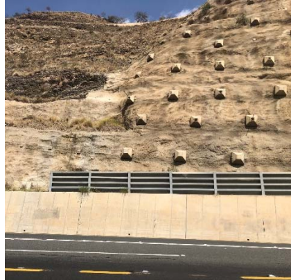
صورة (2) رش المنحدرات بسائل أسمنتي في أحد المواقع بالطريق
